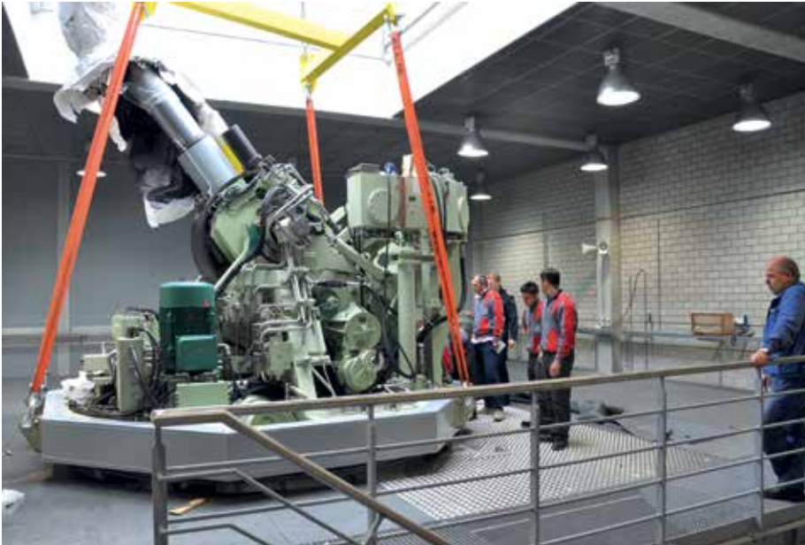
Die Schulungsversion mit gekürztem Rohr wird an der Marineteknikschule installiert (Foto: PIZMarine)
