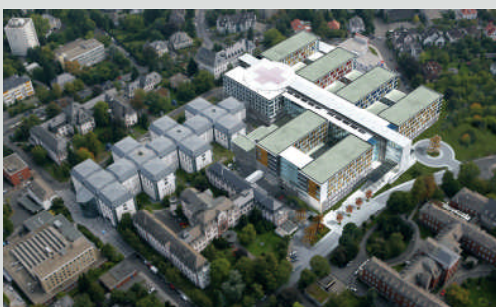
Uniklinikum Gießen und Marburg: Dauer-, Spitzen- und Notstrom von MTU Onsite Energy (Gesamtanlage mit derzeit im Bau befindlichen Neubau)
