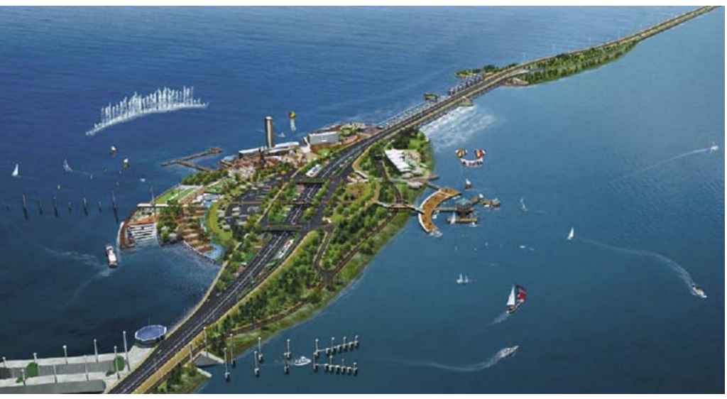
Das mit 250 MW weltgrößte Gezeitenkraftwerk in Sihwa (Südkorea) soll 2009 elektrischen Strom erzeugen.
