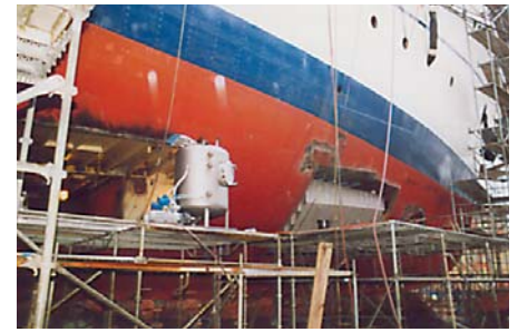
Einbau der Abwasseraufbereitungsanlage (Foto: Manfred Ohde)
