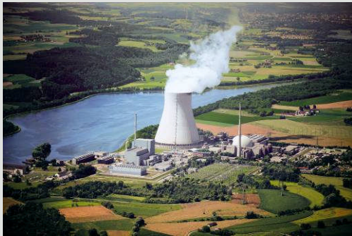
Das Kernkraftwerk Isar 1 erhält neue Notstromaggregate von MTU mit rund 10.000 kVA Leistung.
